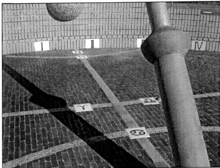
Fig. 7. De meridiaanlijn treft de uurschaal op 13:38 uur, passend bij de lengtecorrectie van 9\frac{1}{2}^\circ . Er zijn slechts drie datumlijnen aangebracht. De foto is genomen op 9 oktober; de schaduw van de index valt al even ten noorden van de equinoxlijn.
