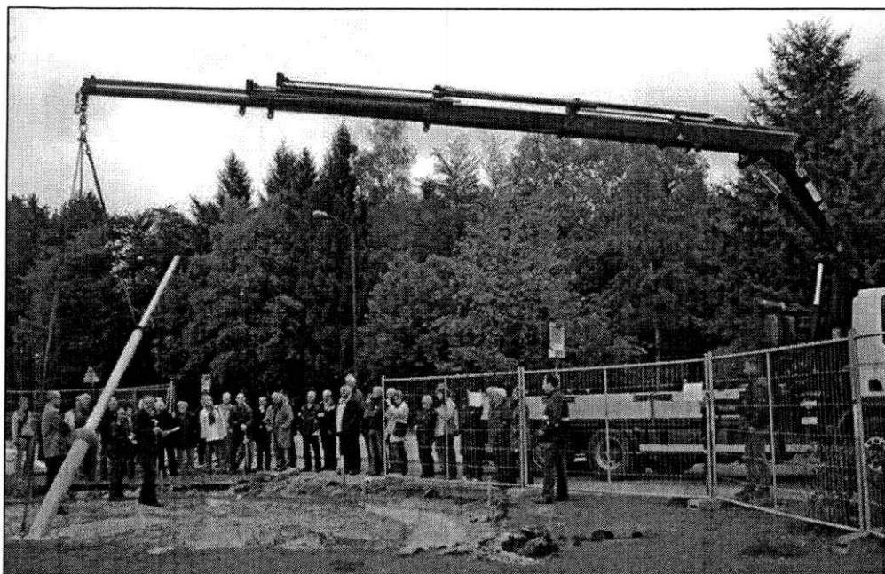
Fig. 3. Plaatsing van de 5.14 meter lange en zwaar verzinkte poolstijl. De 'kraag' op de stijl is de index, waarvan de schaduw de datum zal wijzen. (foto NUFoto)
